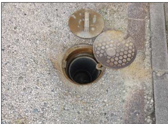
001_C_1 (ます蓋取外し状況)
