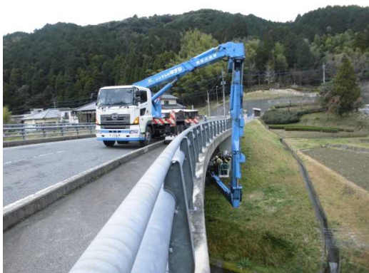
橋梁点検車による定期点検
