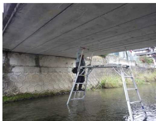
定期点検（打音検査）状況
