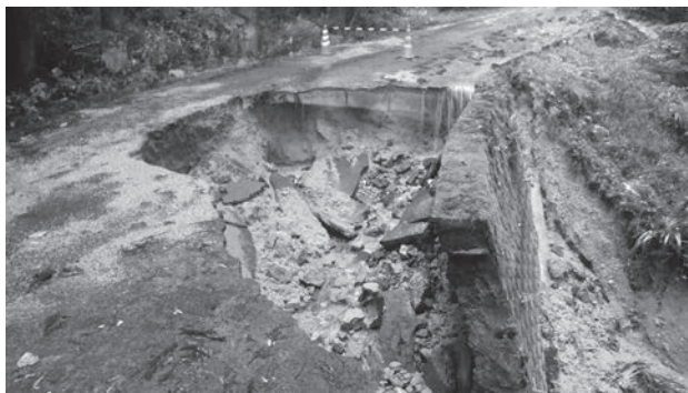
大雨により崩落した道路
