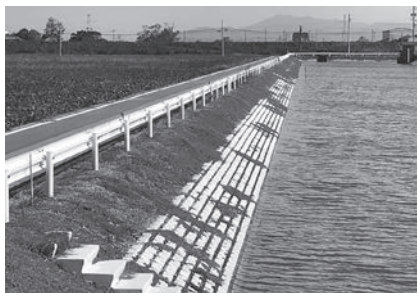
安全対策が必要なブロックマットの排水口の開閉操作
