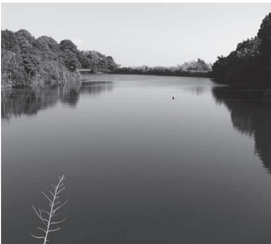
「防災重点ため池」認定：日の尺ため池
