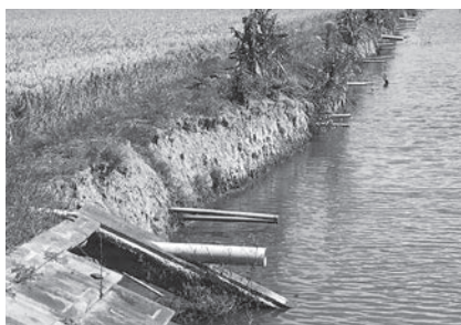
のり面崩落で排水口の開閉操作が困難
