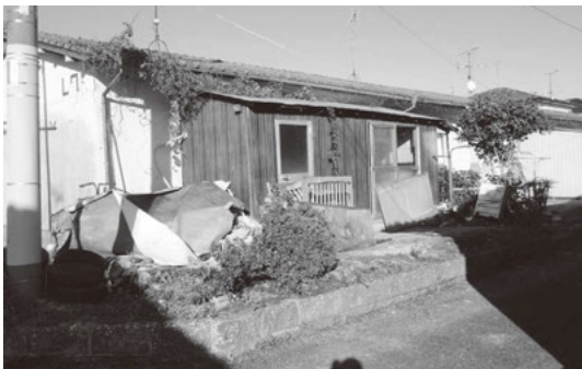
老朽化が進んでいる市営住宅
