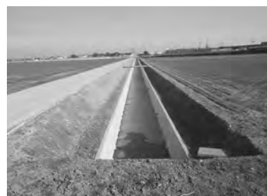
▲農業基盤整備促進事業（水路工事施工後）
