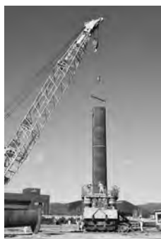
▲新庁舎の基礎杭施工
