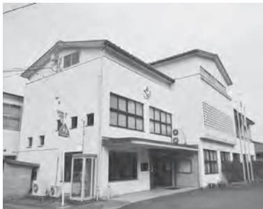
▲解体予定の脊振支所
