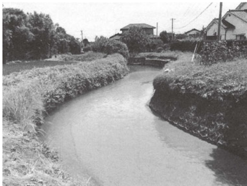
河川改修が待たれる三本松川（竹原地区内）
