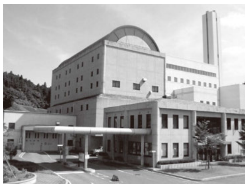
脊振広域クリーンセンター
