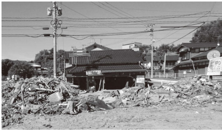
九州北部豪雨の被害を受けた朝倉市の扇状地区内
