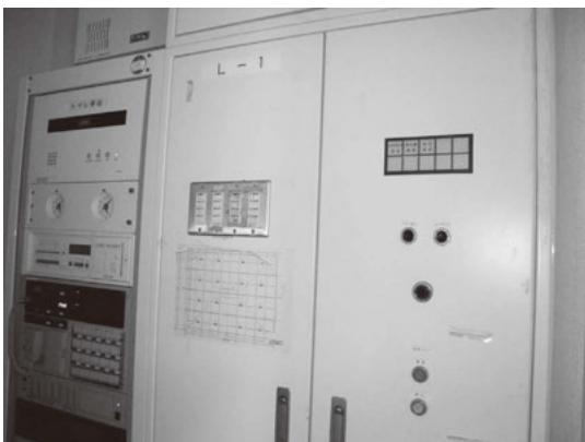
設置されている脊振勤労者体育館の空調設備
