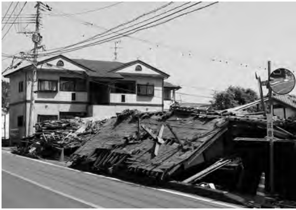
▲被災した家屋の様子
