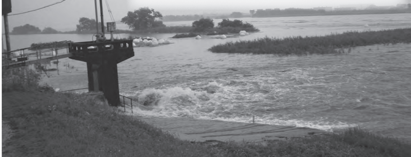
▲平成24年7月、大雨時の江見排水機場（上）付近
