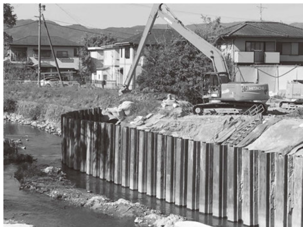
姉川橋の改修
