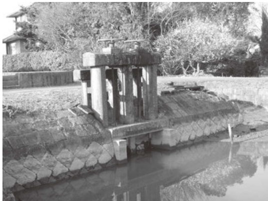
中津江川終点の大野の樋門
