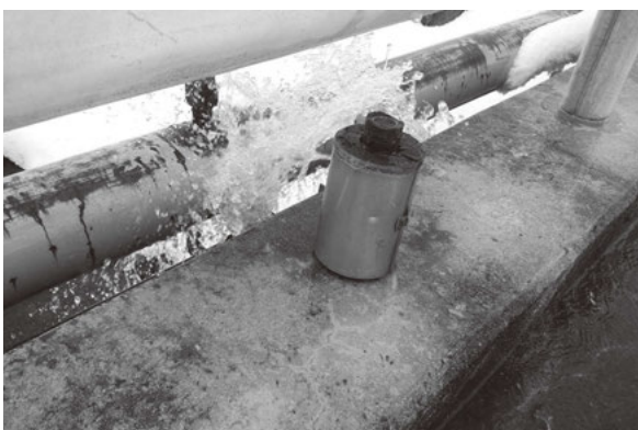
市内の空気弁破裂の様子
