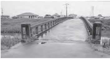
▲整備前の新宿橋
