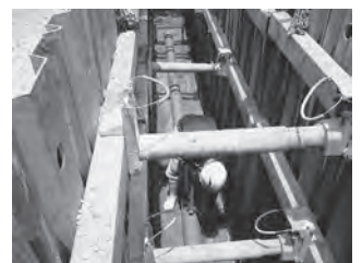
▲下水道開削工事
