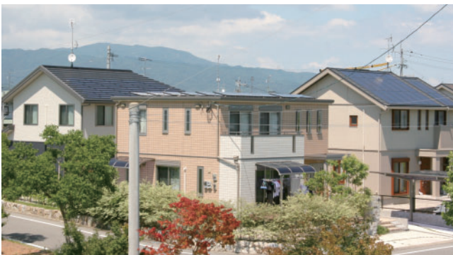
住宅に設置された太陽光発電パネル 神崎町犬の目バインピア付近
