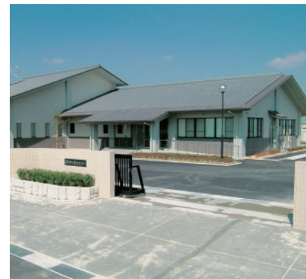
神崎浄化センター
