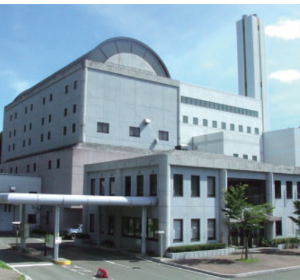
脊振広域クリーンセンター
