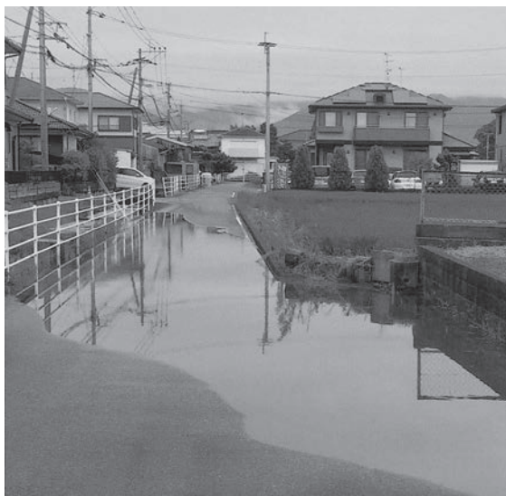
冠水した道路
