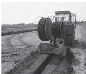
▲ 圃場整備地区内のトランチャー施工による暗渠排水工事
