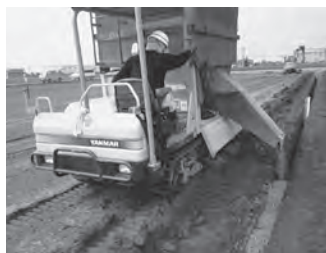
▲ 圃場整備地区内のトランチャー施工による暗渠排水工事
