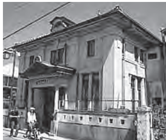
◀ 整備を行う旧古賀銀行 神崎支店
