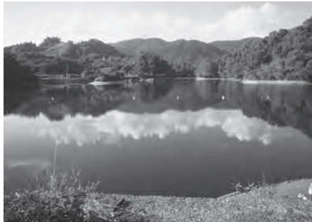
▶日の尺ため池 (神崎町平山地区)
