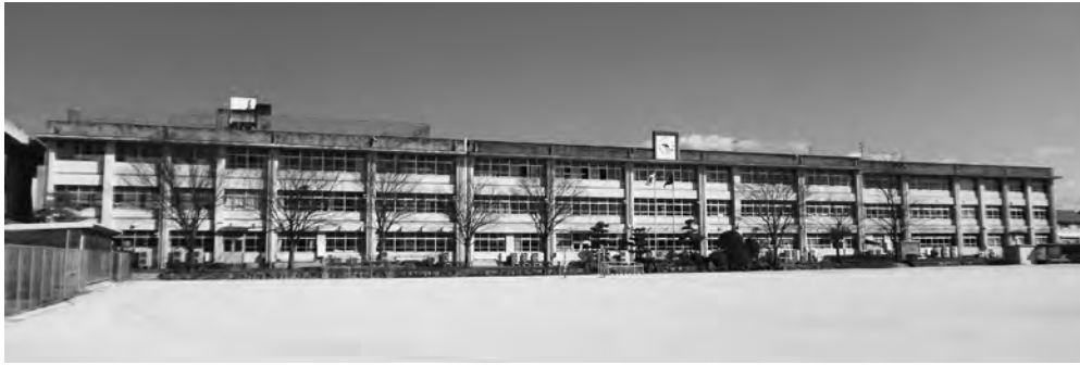
▲改修工事を行う千代田中学校校舎
