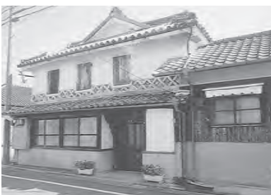
▲長崎街道に面した原岡家住宅
