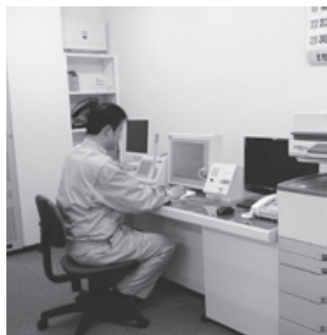
市役所に設置された防災行政無線設備
