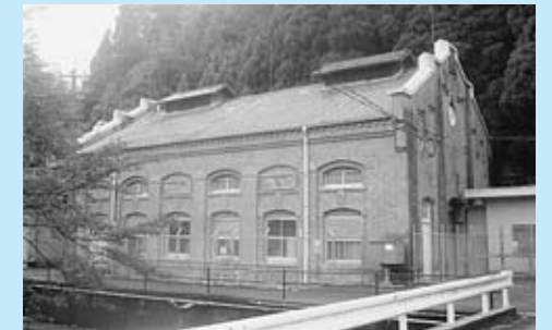
▲九州初の「広滝第一発電所」
