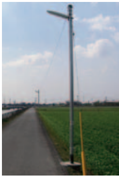
▶防犯灯整備14基（中津地区）
