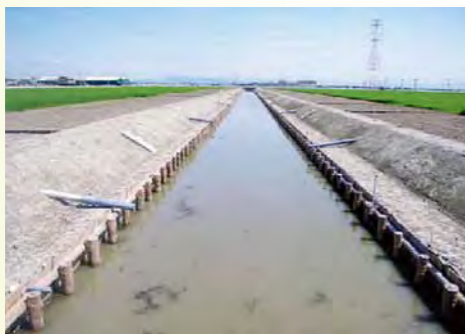
▲クリーク法落対策工事
