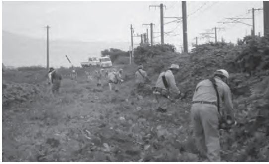
▲多面的機能支払交付金事業を活用した草刈りの様子
