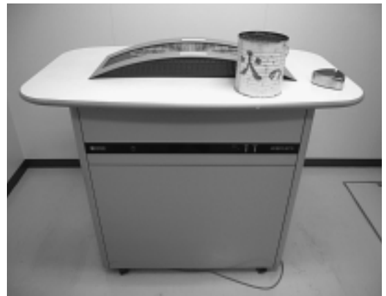
千代田庁舎 喫煙室用空気清浄機
