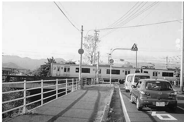
安全対策が急がれる踏切
