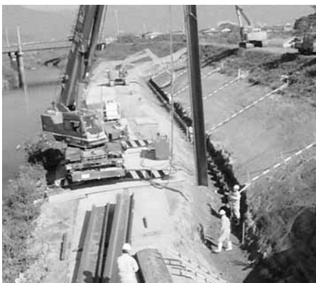
漏水していた場所の改修整備がなされている犬の目地区の城原川堤防
