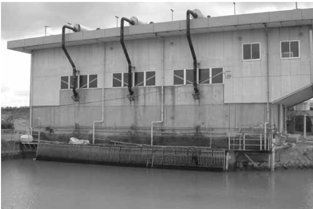
中津地区 排水機場
