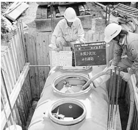
浄化槽の建設現場
