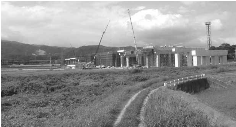
新幹線 鳥栖地区建設中の現場
