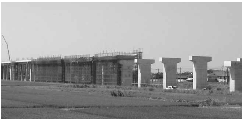
新幹線 鳥栖地区建設中の現場
