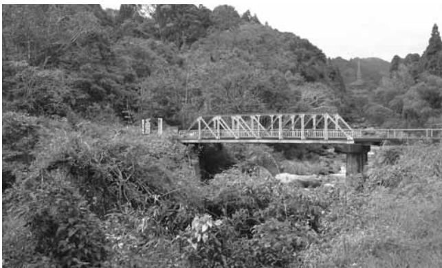
ダム直下予定地付近 (仁比山)
