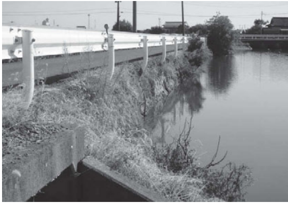
法落ち激しい危険な市道
