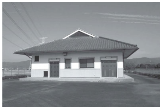
横武地区農業集落排水処理施設
