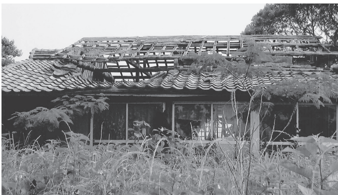
老朽化して放置された空家
