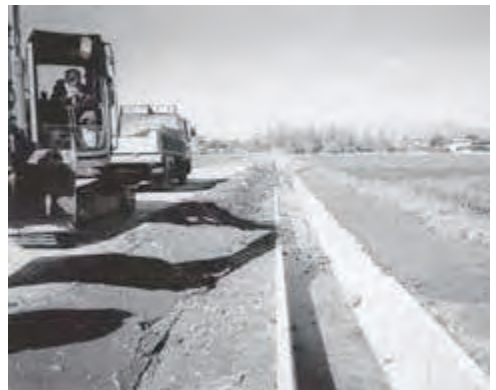
暗渠排水工事
