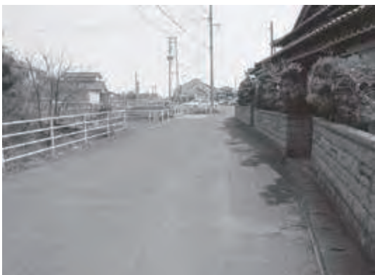
電柱が障害となっている市道
