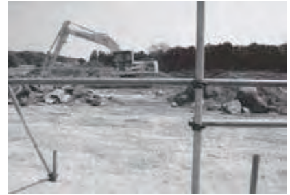
造成中のメガソーラー決定地(神崎市)
