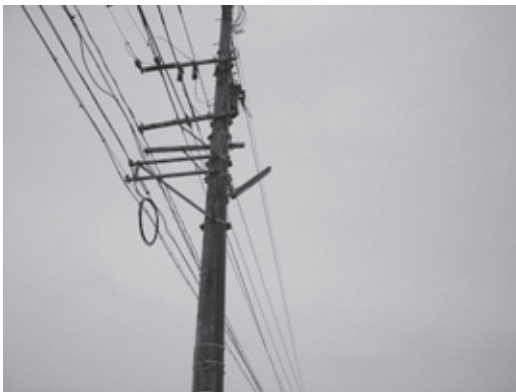
防犯灯 (市道国営千代田西1号線)
