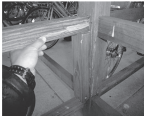
危険な状態の駐輪場（千代田中学校）
