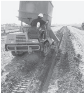
トレンチャー掘削及び吸水管理状況
