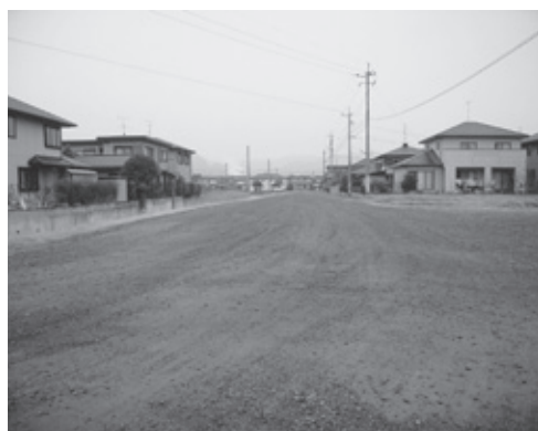
朝日団地道路ジャリ道
