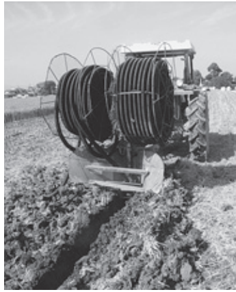
トレンチャー掘削及び吸水管理状況
