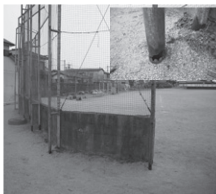
危険なバックネット支柱の腐食(神崎小学校)
