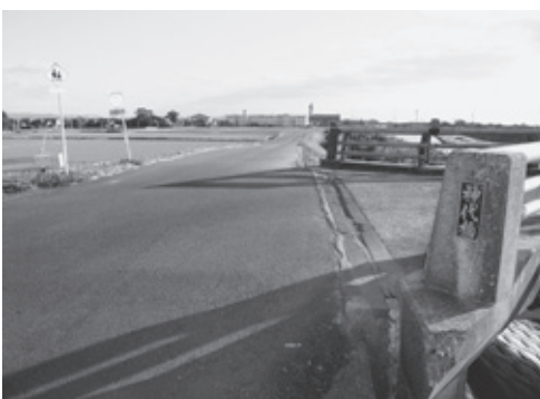
交通事故対策を急げ(千代田町 城原川堤防の神代橋交差点)
