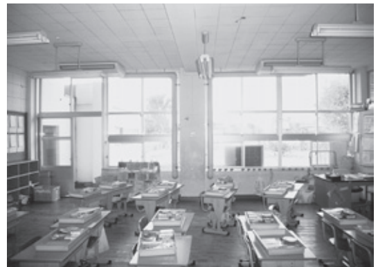
千代田東部小学校北校舎に設置しているエアコン
