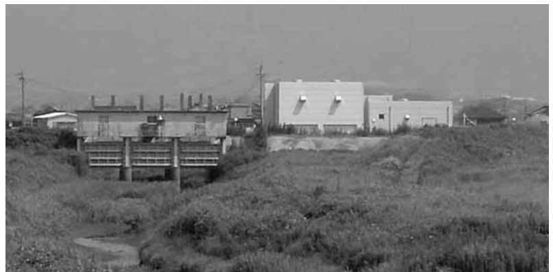
蔵戸方面より三本松川排水場
