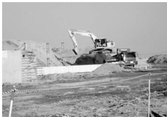
公共下水道神崎浄化センター土木工事
