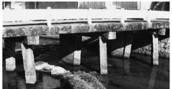
馬場川に架かる、橋げたが曲がって欄干のガードレールも錆がひどい橋梁
