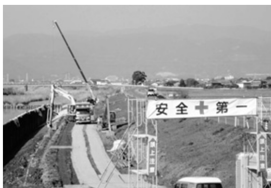
城原川堤防護岸整備工事
