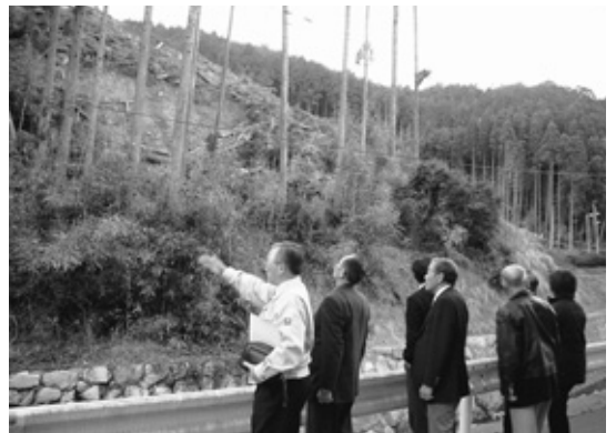
急がれる脊振の風倒木による土砂崩れ流木の防止対策
