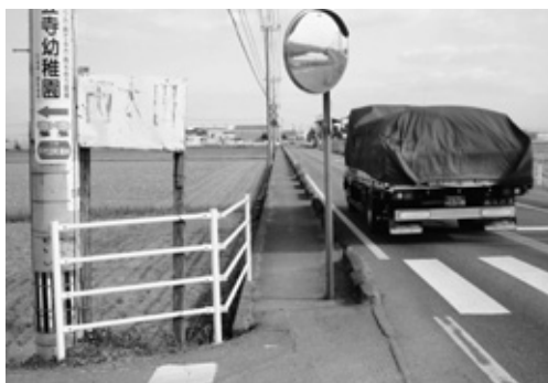
狭く転落防止柵が必要な歩道 (嘉納バス停東側)
