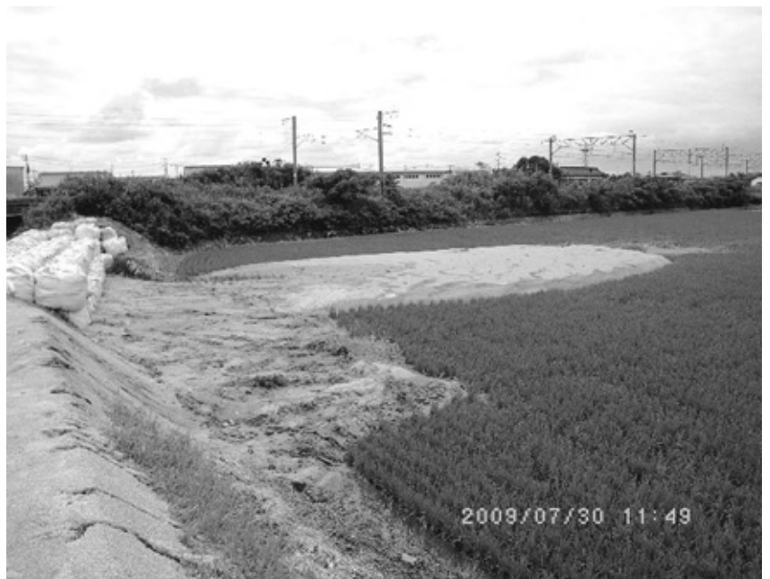
早急な補強工事が必要な三本松川右岸の堤防
