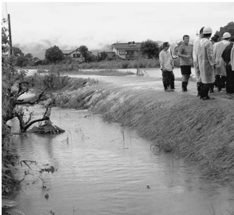
城原川堤防の越水状況（野越し）
