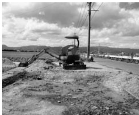
千代田西1号線の道路整備状況
