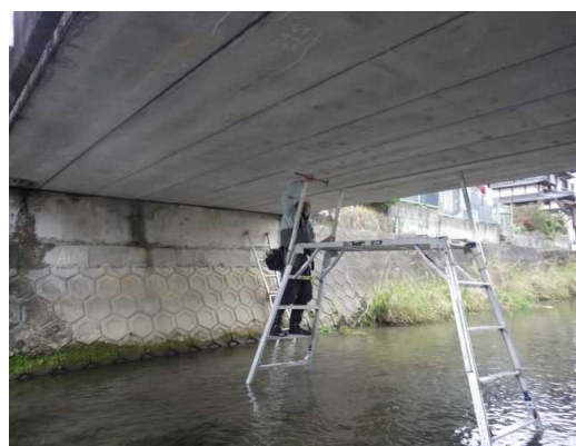
定期点検（打音検査）状況
