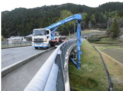
橋梁点検車による定期点検
