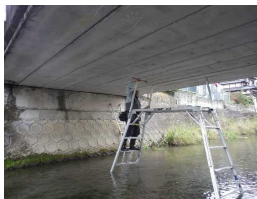
定期点検（打音検査）状況
