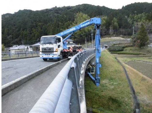
橋梁点検車による定期点検
