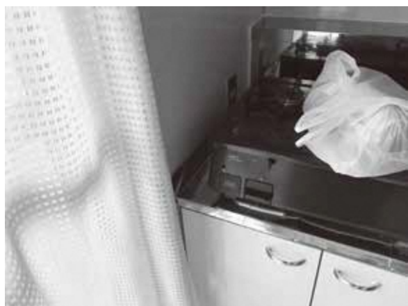
台所カーテンとガステーブルが接近し、火災の危険
