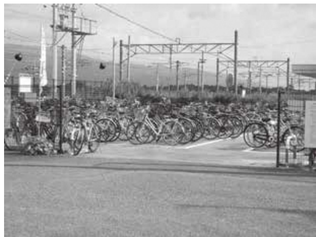
屋根がない駅南口駐輪場
