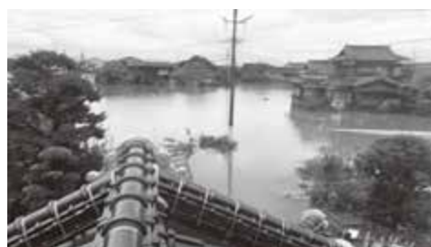
令和3年8月豪雨時に内水氾濫した中津地区
