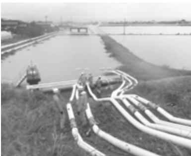
▲排水ポンプ車を使った排水作業の様子
