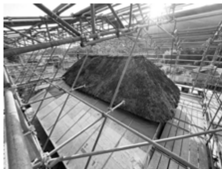
▲伊東玄朴旧宅の工事の様子
