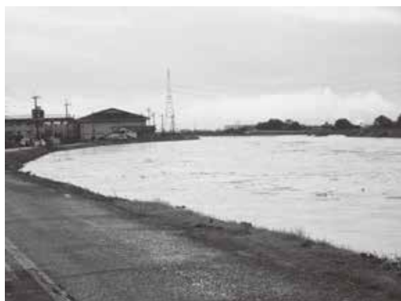
平成21年7月豪雨時の城原川中下流域の状況
