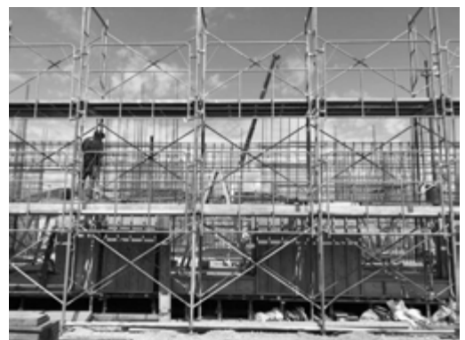
▲建て替え工事中的の本堀団地
