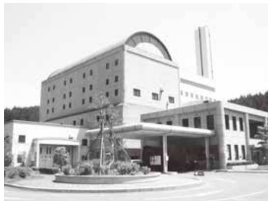
令和 5 年度で稼働終了見込みの脊振クリーンセンター
