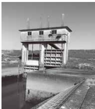
国営三田川出来島排水樋門
