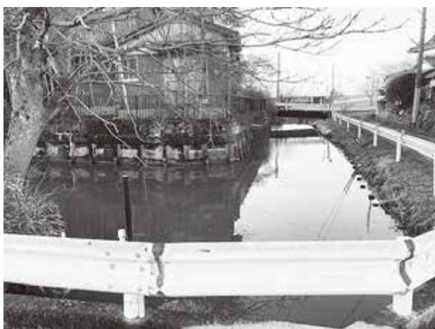
泥土が堆積し、水の循環ができない地区内の水路
