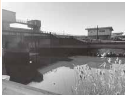
造成更新中の江見手水門、江見上流・下流排水機場
