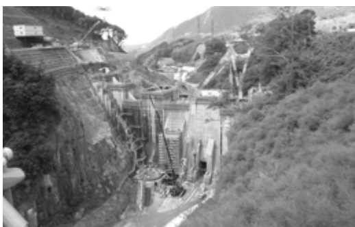
建設中の立野ダム（流水型ダム）
