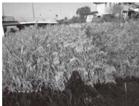
集落内の整備が必要な水路
