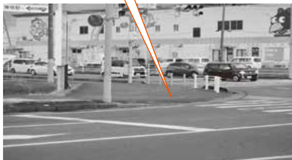
防護柱設置がない市道交差点
