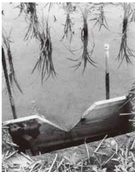
田んぼダムとして排水口に設置された止水板
