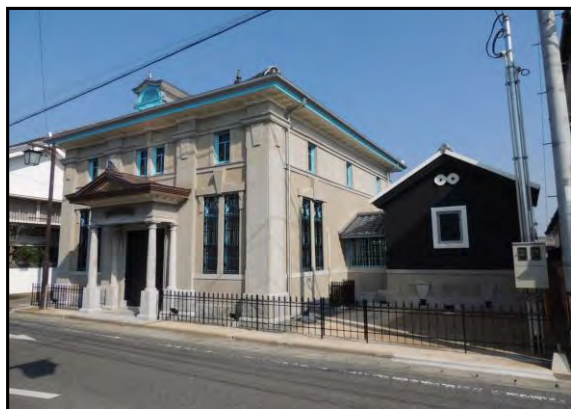
復原工事が完了した旧古賀銀行神埼支店
