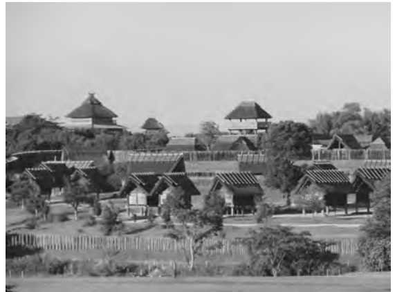
公園西口「あそびの原」付近より復元建物遠景
