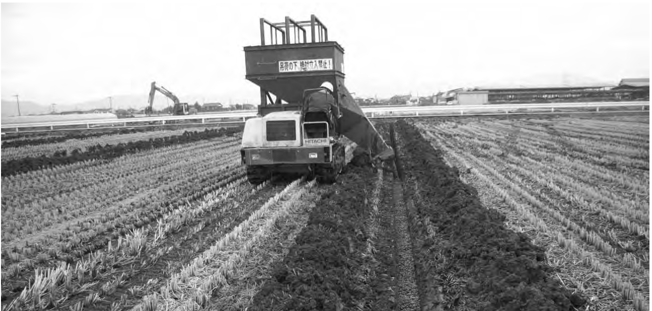
暗渠排水工事の様子
