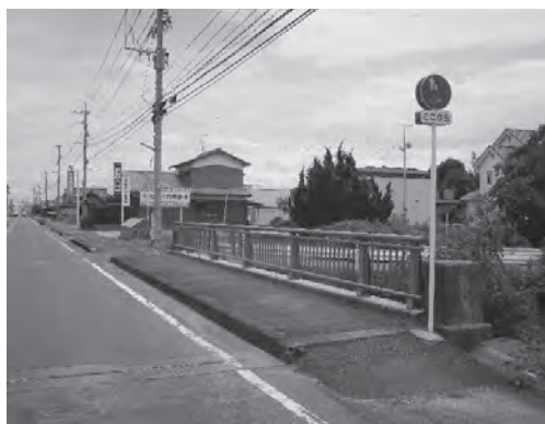
危険な段差が続く歩道(直鳥地区)
