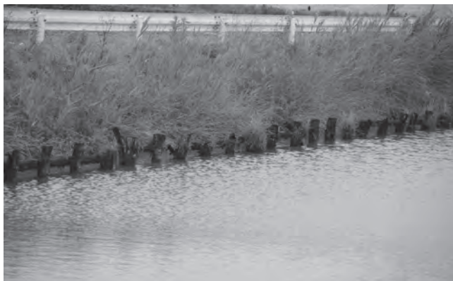
柵板が無くなった板柵工（大詫間幹線水路）
