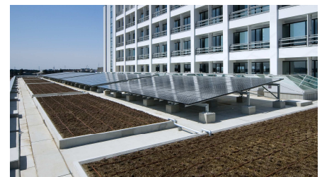
太陽光発電事例（つくば市）
