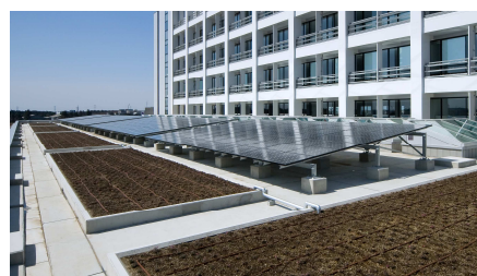
太陽光発電事例（つくば市）
