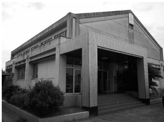
工事対象の一つである千代田西部小学校体育館
