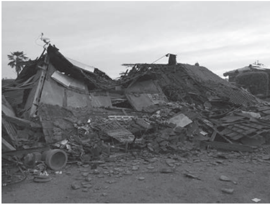
熊本地震による民家の倒壊 神崎市も備えが必要である
