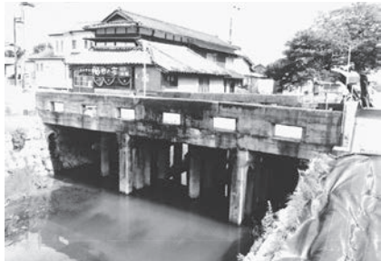
架け替え工事計画のある土井の上橋(東信用組合東側)
