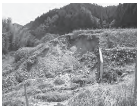
▲農地(水田)の法面崩壊状況
