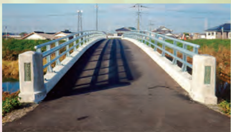
▲老朽化対策で改修された「新宿橋」
